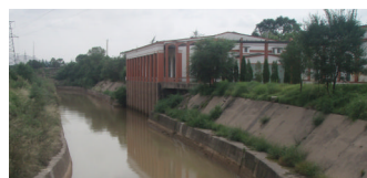
黄河導水路に設置された取水施設: この日の濁度は3,000HTU(HTUとは黄河独自の濁度表記、1NTU≒0.5HTU)
