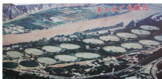
蘭州市第1浄水場(Q=153万m 3 /d): 直径100mの円型沈殿池が18池並ぶ景観は圧巻
