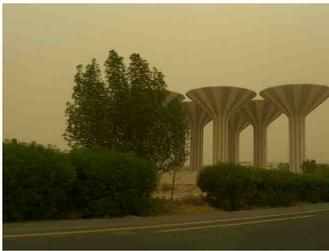
写真1: 逆三角錐の配水高架水槽
